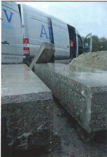
Beton platen op maat zagen
